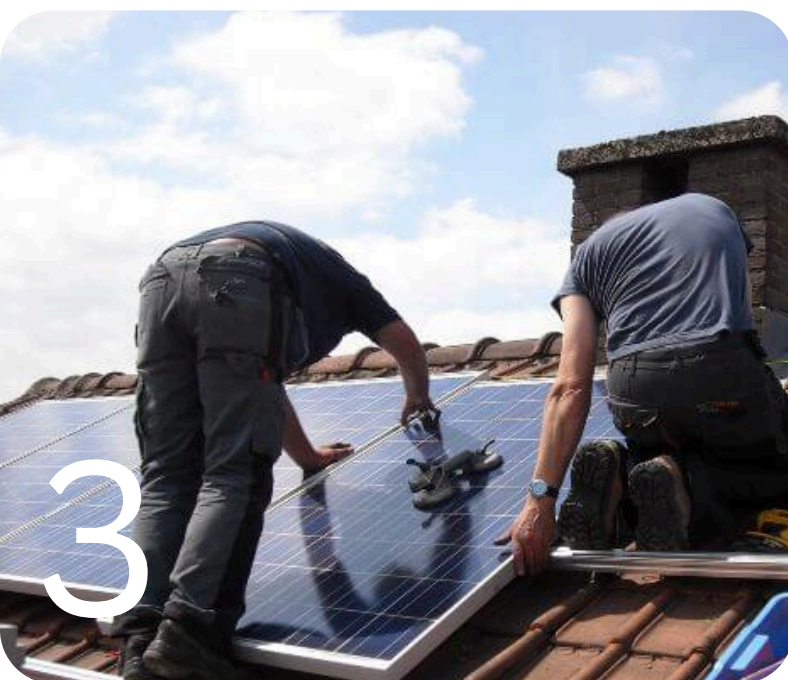
Installation des panneaux photovoltaïques
