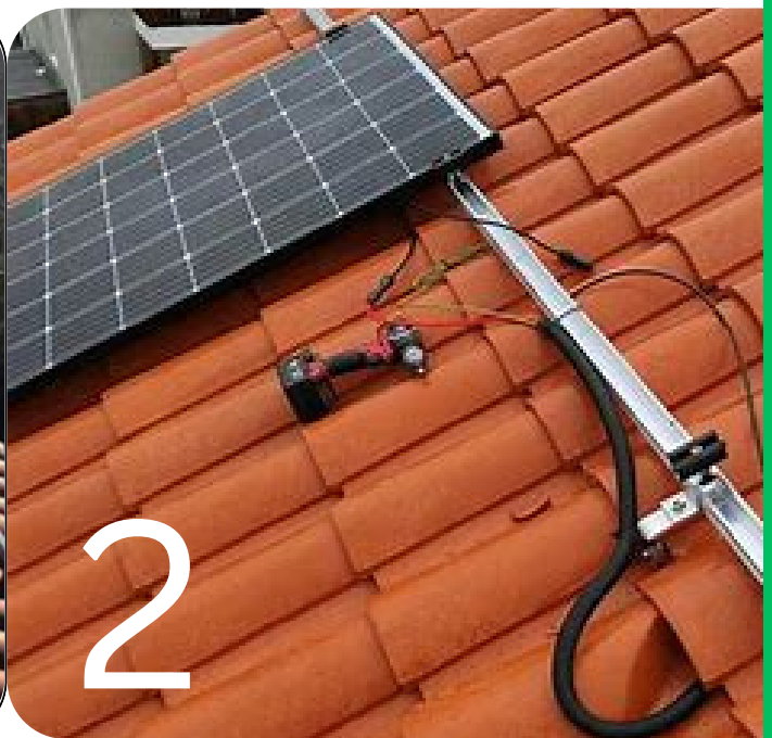
Mise en œuvre du réseau électrique
