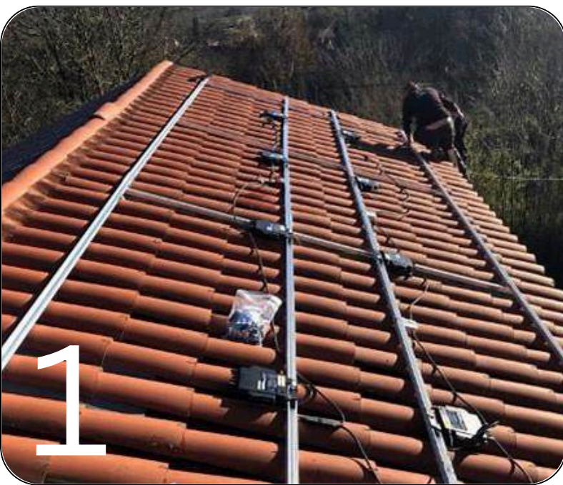
Pose des supports sur toiture
